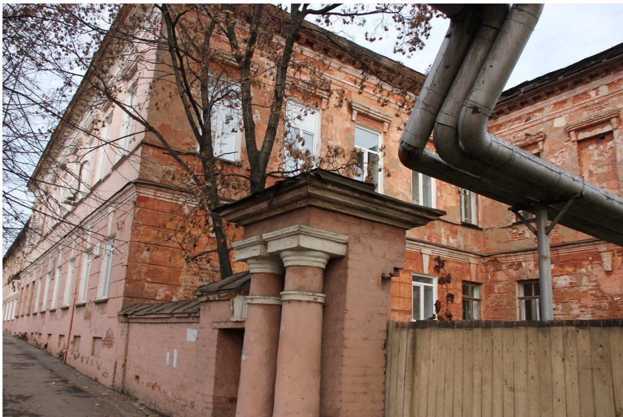
Фото № 2 от 07.10.2016. Южный фасад.
