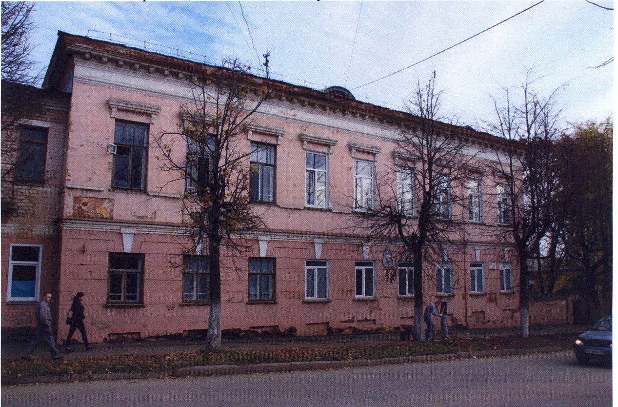
Фото № 1 от 07.10.2016. Главный уличный фасад.
