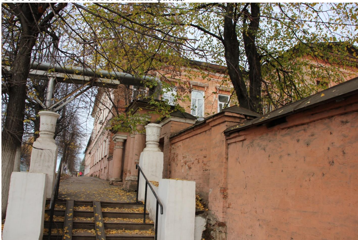
Фото № 3 от 07.10.2016. Южный фасад.
